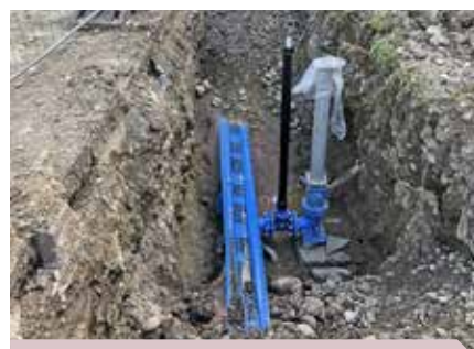
I naďalej pokračujeme v budovaní systému hydrantovej sústavy.
